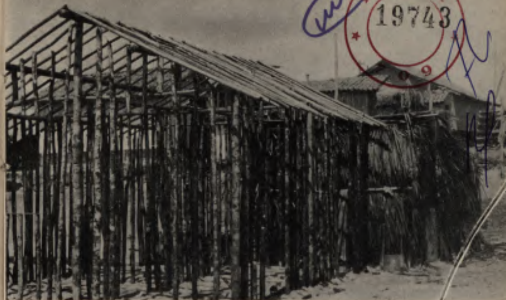
No fundo, vê-se o pequeno mocambo de palha, levantado provisoriamente. Na frente, a morada definitiva, ainda em estacas, idealizada e construída, de acôrdo com o "gôsto arquitetônico" do proprietário.
